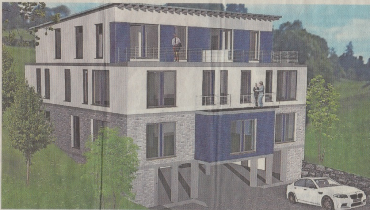
In der Barbarossastraße entsteht derzeit das „Kinzig Valley“.
